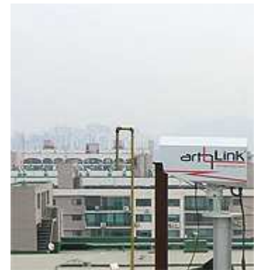
Атмосферная оптическая система передачи данных M1 ARTOLINK (ООО МОСТКОМ) в Белгороде - дистанция связи 0.8 км
