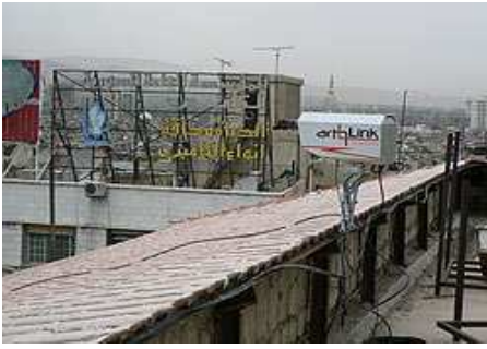
FSO оборудование M1 ARTOLINK (ООО МОСТКОМ) в Сеуле - дистанция связи 1.1 км
